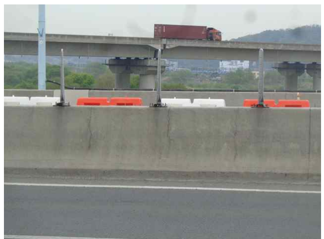
■ 부 재 : S8 ■ 손 상 : 중앙분리대 균열(폭 0.1mm)
